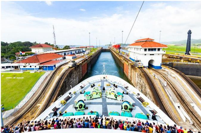
**船が上昇!?高低差26mの水の階段**
